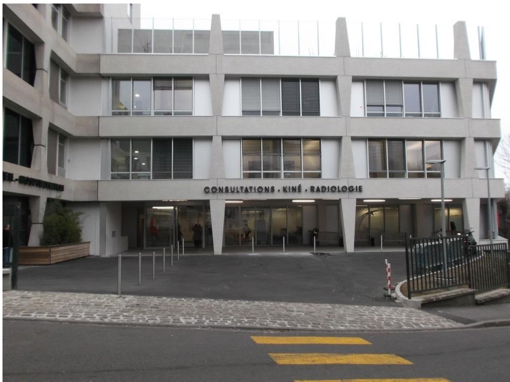
Nouvelle aile avec les chambres particulières
